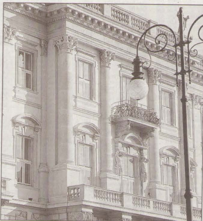
Dettaglio della facciata della sede della giunta di piazza Unità
